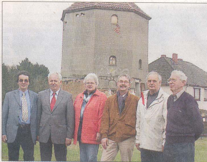
Für die Arbeitsgruppe Ritterhuder Mühle mehr als ein Glücksfall: Ein Unternehmen aus Bremen führt gegenwärtig kostenlos die Entkernung des Gebäudes vor. Unser Foto zeigt v. li. Jürgen Großmann, Sponsor Dieter Marquardt, Hannelore Monsees, Architekt Hans-Joachim Riemer, Peter-Michael Meiners und Friedemann Heilshorn.
