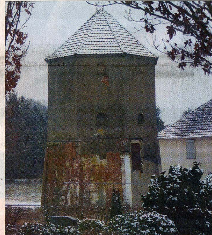
Bereits zum Hammeffest 2006 sollen alle Umbauarbeiten an der Alten Mühle abgeschlossen sein.
